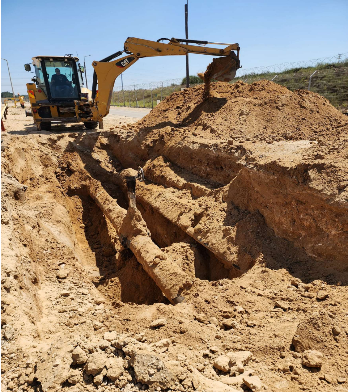
איור 1- חפירת גישוש לאיתור הקו
